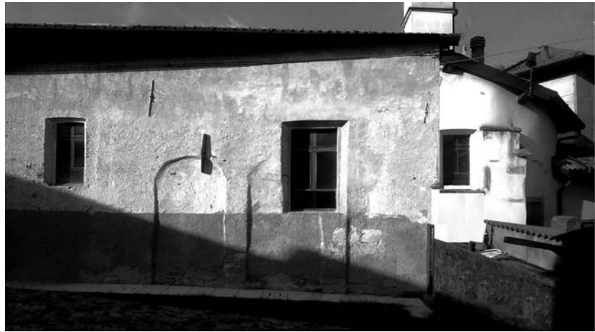
Fig. 2 - Crosio della Valle, chiesa di Sant'Apollinare, il perimetrale Sud della chiesa altomedievale, con arcature sottosquadrate
